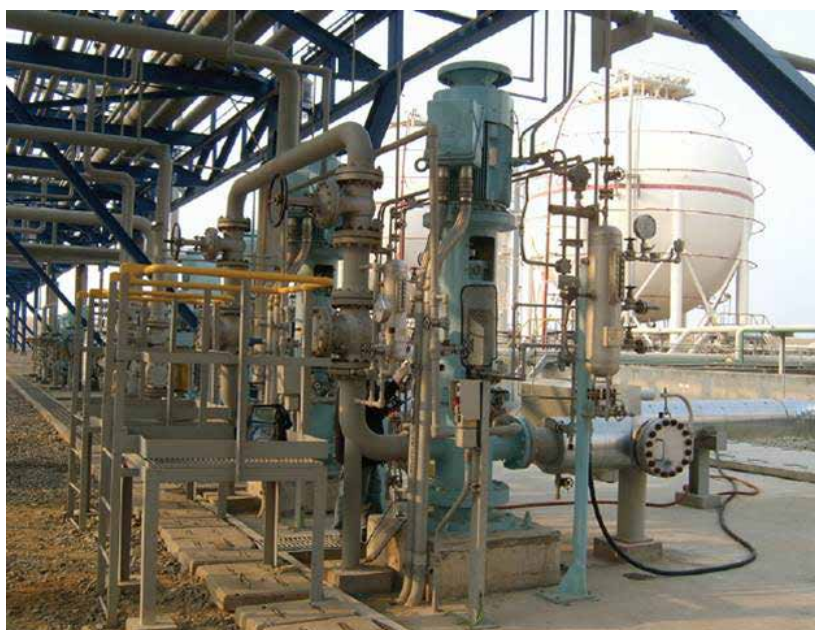
Ein typisches Element dieser Anwendungen mit großer Förderhöhe ist das Pumpen von Kohlenwasserstoffen mit geringer Dichte in einer VS6 Ansaugkanal-Anordnung.
