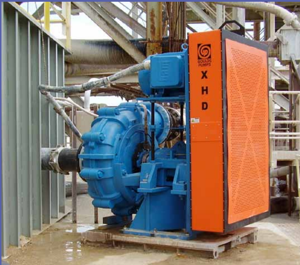
Первичный насос песчаной пульпы на дробильно-сортировочных комплексах
