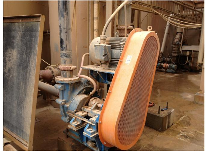
El modelo 125XHD superó las 5000 horas de funcionamiento sin problemas más allá del cambio estándar de los anillos de empaquetadura.
