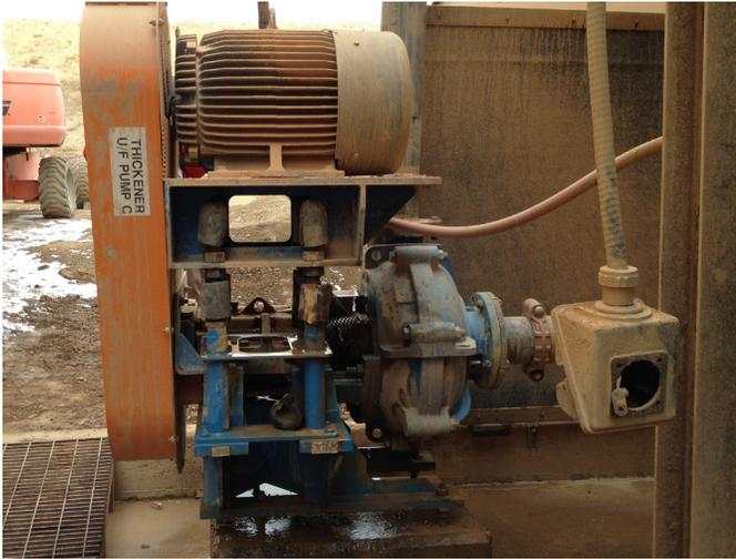
El montaje tipo horquilla permite un fácil acceso al área de la caja de empaquetadura sin necesidad de desmontar el motor.
